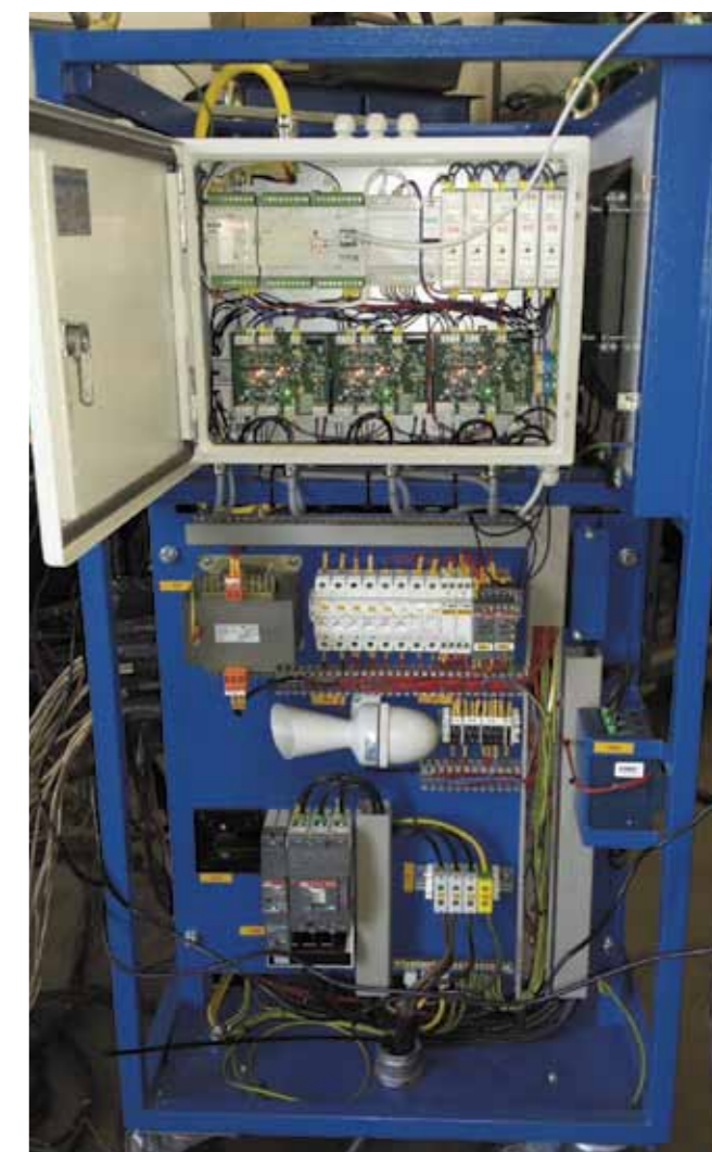
Obr. 17. Žhací jednotka – řídicí elektronika a jištění
