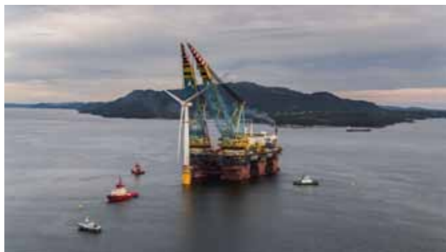
Instalace větrné elektrárny Siemens Gamesa na plovoucí základnu v Norsku.
