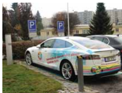
Mini nabíjecí stojan 16 A, Jablonec nad Nisou
